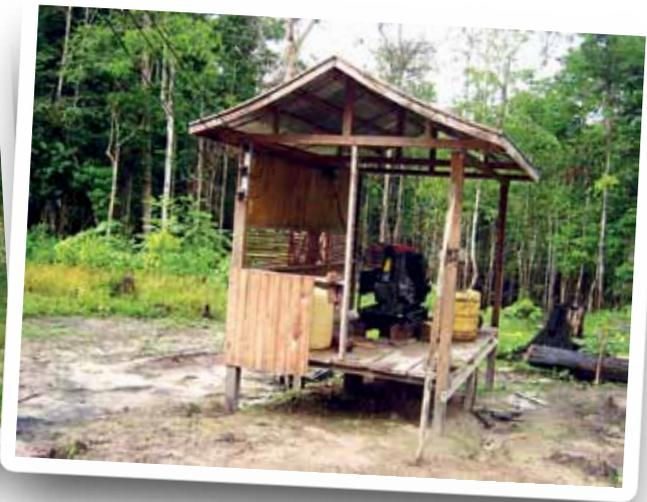
Estruturas de madeira onde ficam os motores geradores de luz, para proteção da chuva e diminuir o barulho durante o funcionamento.
