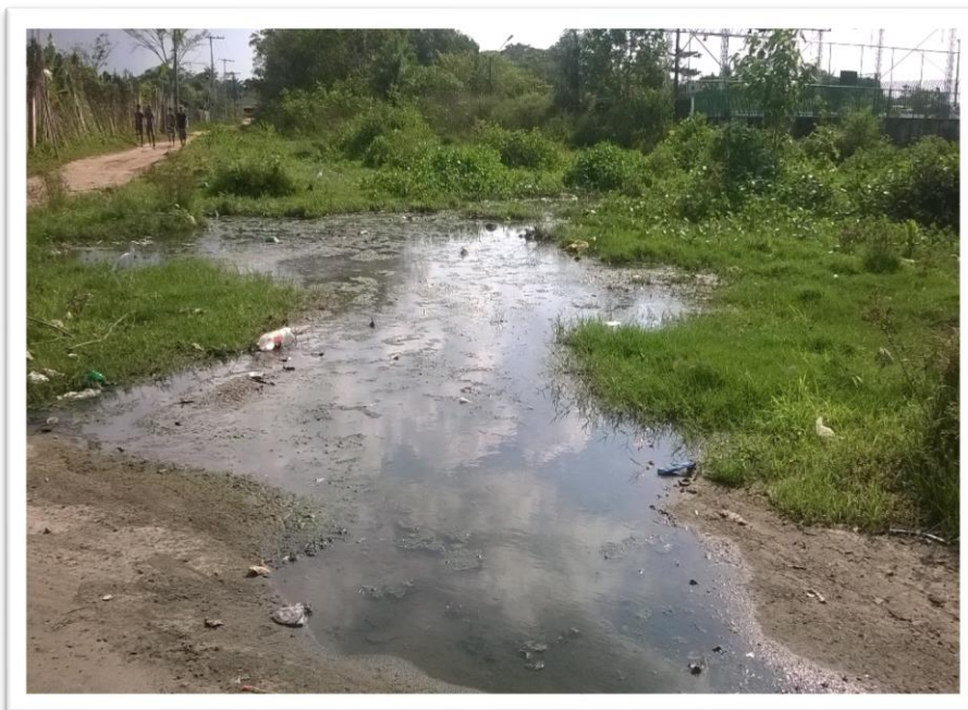
Figura 15 - Poça formada de esgoto em pleno verão amazônico
