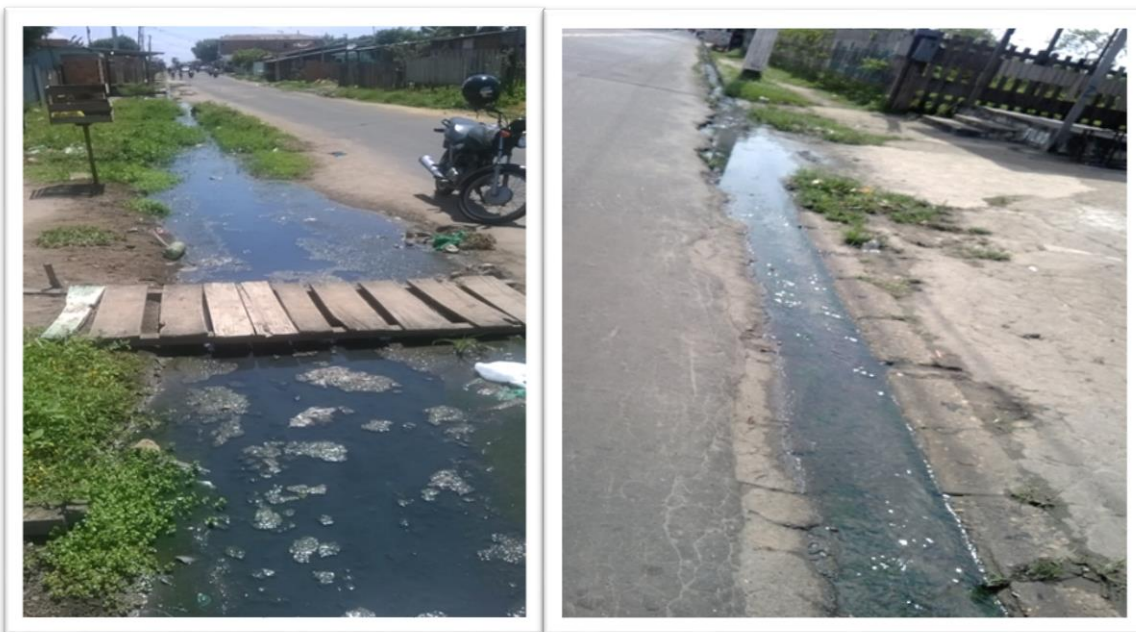
Figura 16 - Rua com baixo declive e obstruções Figura 17 - Rua com médio declive
