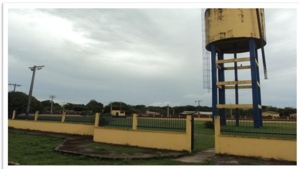
Figura 12 - Estação de bombeamento do bairro Itaúna II
