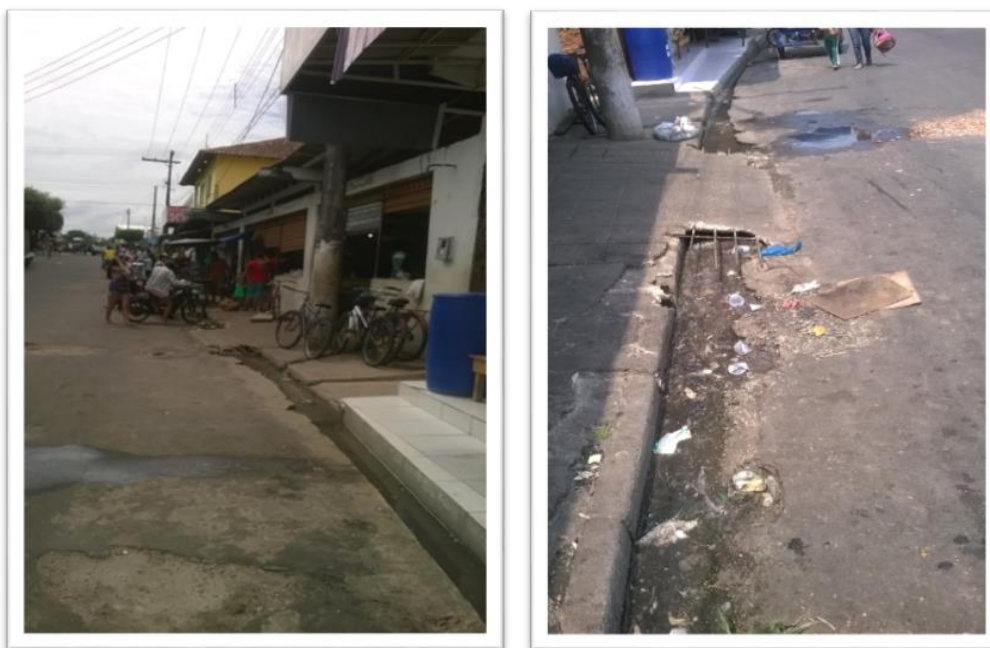
Figura 33 - Esgoto a céu aberto na entrada da feira do bagaço
