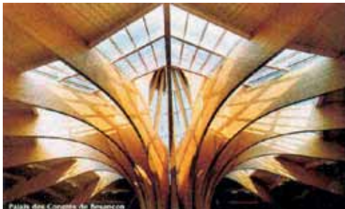
Figura 5: Exemplo de construções com vigas laminadas Fonte: www.micropolis.net/besancon
