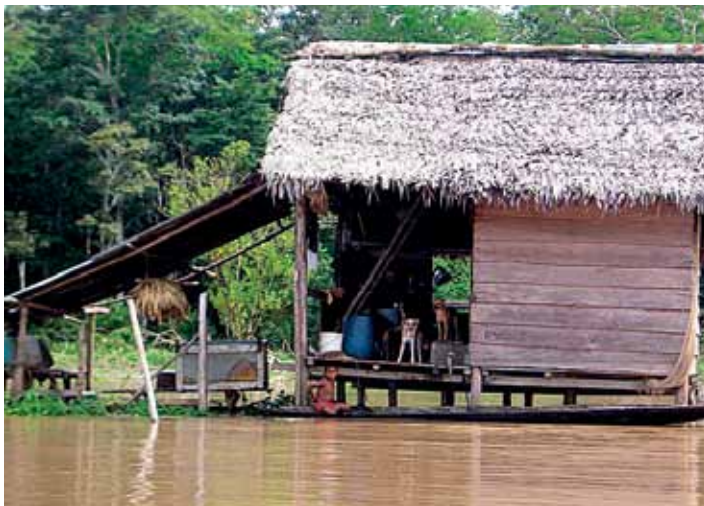
Figura 14: Casas construídas em áreas de várzea
